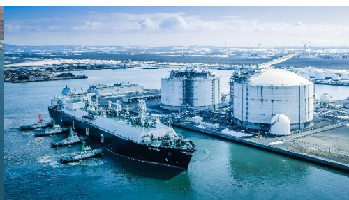
(Reference: The Company’s Ishikari LNG Terminal)
