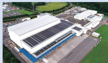
太陽光発電設備（阿見工場）
