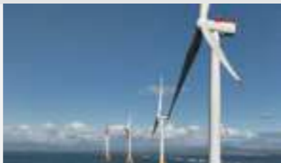
8MWの大型風車を支える 日本初の「ジャケット式基礎」 (石狩湾新港洋上風力発電所)
