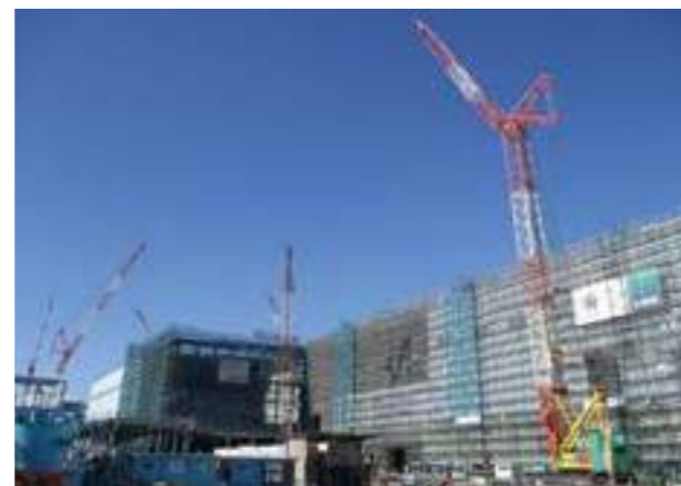
名古屋製鉄所 次世代型熱延ライン建設風景
