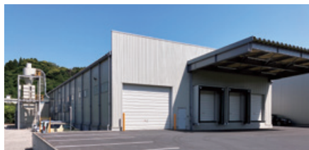
千葉紙器工場 拡張部分の建屋外観
