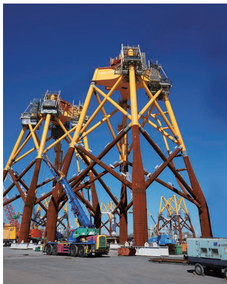
石狩湾新港洋上風力発電所に採用されたジャケット式基礎
