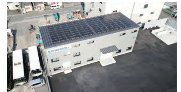
屋上に太陽光発電設備を設置した京都営業所
