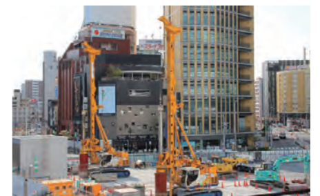
リニア名古屋駅ターミナル駅工事(名古屋駅前)
