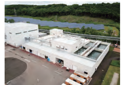
排水処理設備(磯分内工場)
