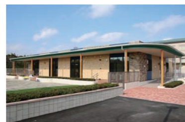
自社保育所 (東日本製鉄所鹿島地区)
