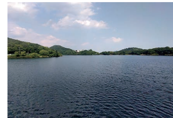
瀬戸内製鉄所 広畑地区 桜山貯水池
