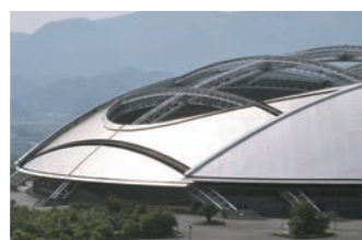
建築向け長寿命化、耐久性向上、信頼性向上 チタン製屋根
