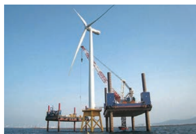
ジャケット式洋上風力発電設備を北海道石狩湾で建設中。写真は北九州市沖の実証設備。
