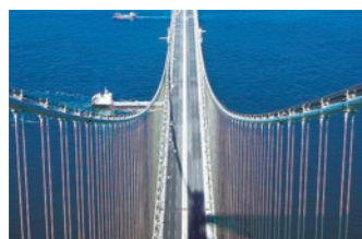
土木向け施工効率向上 つり橋用高強度線材
