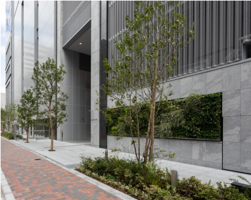
新設歩道および歩道上空地と壁面緑化
