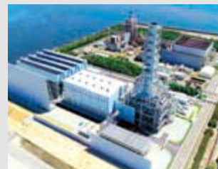
実証設備複合サイクル発電所（第二T地点）
