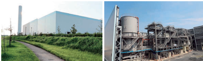
空見スラッジリサイクルセンター下水汚泥固形燃料化施設 (2020年11月運営業務開始)
