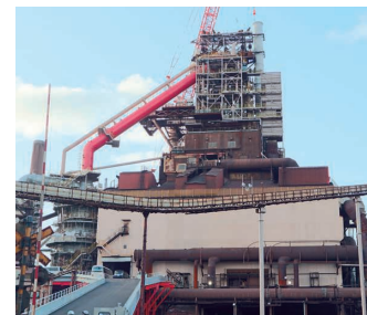
改修後の室蘭製鉄所（北海製鉄株） 第2高炉
