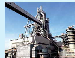
関西製鉄所和歌山地区 新第2高炉
