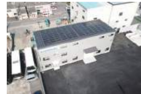
屋上に太陽光発電設備を設置した京都営業所 Solar Power Generation System Installed on the Roof of the Kyoto Branch Office
