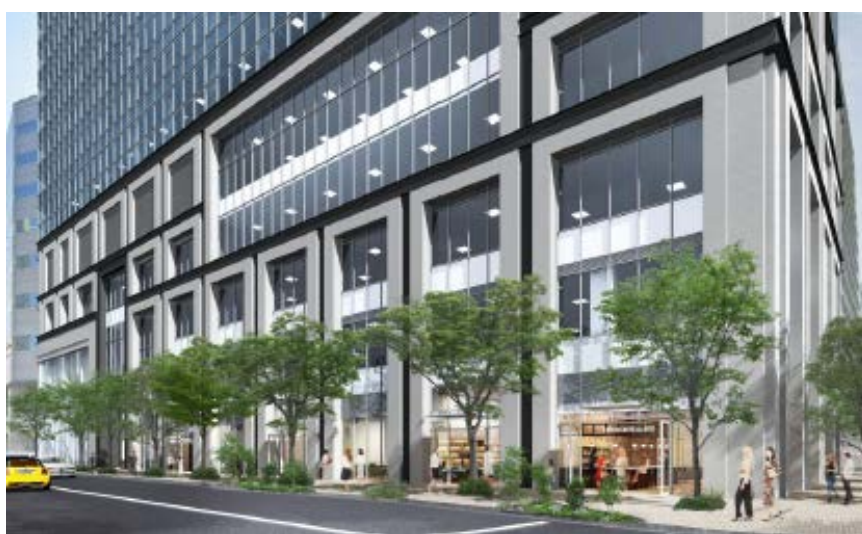
< 建物低層部外観 >
